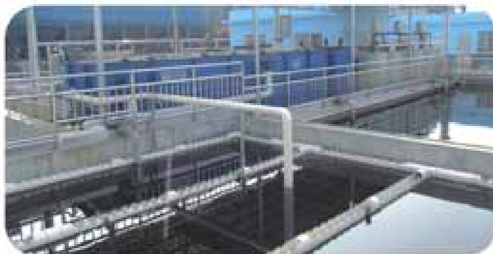
铸造中心污水处理站
