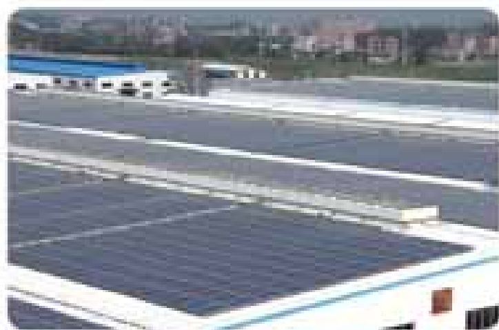
光伏组件整齐地铺设在厂房屋顶
