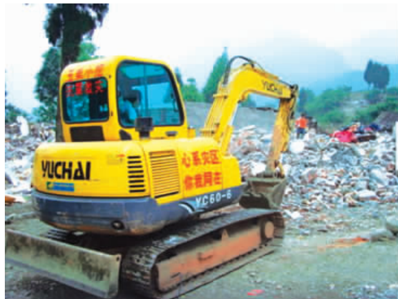
二 救援人员驾驶玉柴挖掘机清理废墟 二
